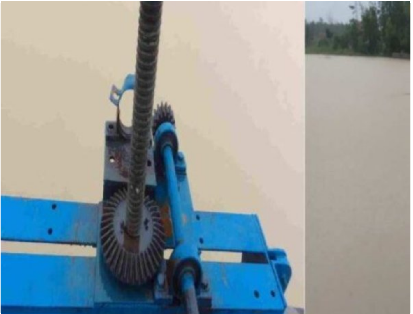
Pintu air Albaret Simpang Mesuji
